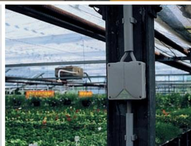
Hochwertiges Material macht's möglich: Bei den Produkten der Serien GTi, Abox-i, Abox-i SL, AKi, TK-PC und ZKi kommt glasfaserverstärktes Polycarbonat zum Einsatz.
