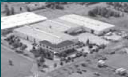
BOSECKER VERTEILERBAU SACHSEN GMBH, ZITTAU
